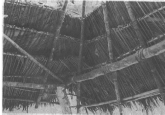
Colocación de la hoja de iraca
